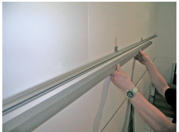
6) Align rail element.
